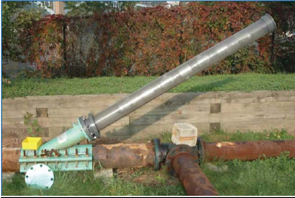
شکل ۴ - نقطه تزریق روبات به خط لوله
